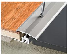
Schrauben Sie jetzt das Deckprofil des Übergangs-...
