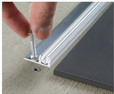
Schneiden Sie das Basis- und Deckprofil an der gleichen Seite auf die benötigte Länge. Verschrauben oder verkleben Sie das Basisprofil auf dem Fußboden. Bei Fußbodenheizung benutzen Sie bitte einen 2-Komponenten-Kleber:
