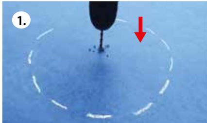
1. Bodenbelag etwa in der Mitte der zu reparierenden Fläche mit 4 mm Bohrer anbohren.
