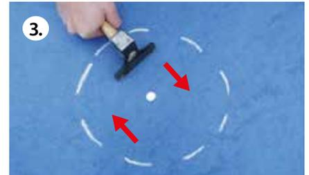
3. Mit dem Anreibehammer Linoleum Doctor zunächst vom Bohrloch weg und anschließend zum Bohrloch hin gleichmäßig verteilen.
