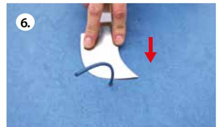
6. Farblich passenden Linoleum-Schmelzdraht erwärmen und in das Bohrloch einführen, überstehenden Schmelzdraht abstoßen.
