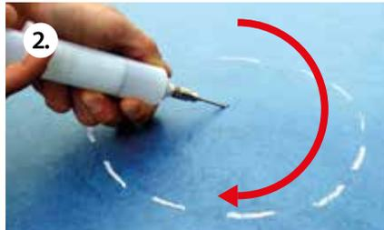
2. Linoleum Doctor sparsam in die zu reparierende Fläche einspritzen. Während der Einspritzung wird die Injektionsspritze kreisförmig bewegt.
