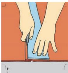
Schneiden Sie die überlappenden Bahnenkanten entlang einer Stahlschiene mit einem Doppelschnitt oder einem Nahtschneider und fixieren Sie anschließend die Naht von unten mit einem einseitigen, weichmacherbeständigen Klebeband.
