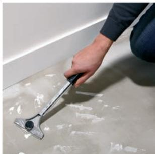
Generell müssen Altbeläge (z.B. Teppich, PVC) vor einer Neuverlegung von Vinylfußböden aus technischen und hygienischen Gründen entfernt werden. Eventuell zurückgebliebene Klebstoff- oder Schaumreste müssen in der Folge ebenfalls entfernt werden, damit Wechselwirkungen ausgeschlossen werden, und eine einwandfreie Verlegung des neuen Belages möglich ist. Verlegungen auf Unterlagen jeglicher Art sind nicht zulässig.
