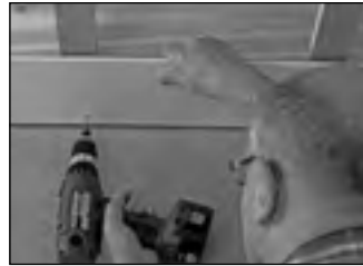
Erstes Steck-Paneel befestigen
