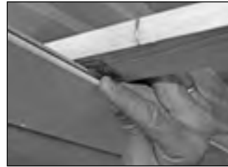
Befestigungskralle setzen
