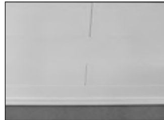
Deckenabschlussleisten aufstecken – fertig
