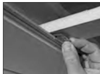
Befestigungskralle setzen
