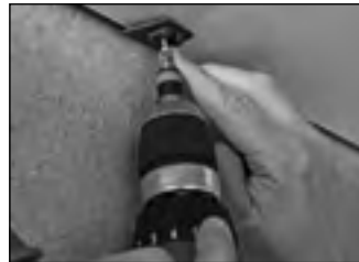
Leistencлип montieren
