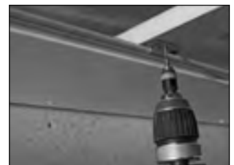
Befestigungskralle anschrauben
