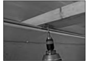
Befestigungskralle anschrauben
