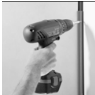
Befestigungsschiene letzte Platte
