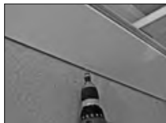
Erstes Steck-Paneel befestigen
