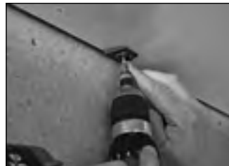
Leistencлип montieren
