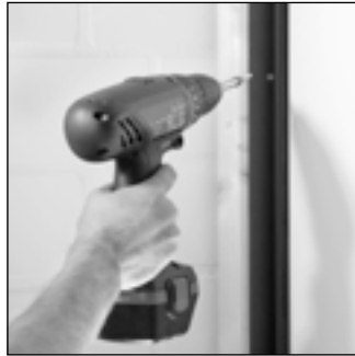
Befestigungsschiene setzen
