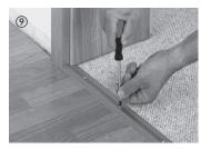
Zur Einhaltung des Dehnungsabstandes muss bei Türübergängen stets ein geeignetes Profilsystem eingesetzt werden. Dies gilt auch, wenn im angrenzenden Raum der gleiche Boden verlegt werden soll. In diesem Fall ist für die Einhaltung der Dehnungsfuge ein Übergangsprofil einzusetzen. In der Schiene ist ein Dehnungsabstand von ca. 5 mm einzuhalten. Grundsätzlich müssen Holztürstöcke in Parkettelementdicke mit einer Feinsäge abgeschnitten werden, damit das Parkett eine Dehnungsmöglichkeit hat.
