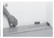
Mit der Nutseite zur Wand wird die 1. Reihe gerade ausgerichtet, stirnseitig verleimt (vgl. Bild 5) und fest mit Abstandskeilen fixiert – umlaufend 10 – 15 mm Wandabstand einhalten. Mit dem Reststück der 1. Reihe wird die 2. Reihe begonnen, dadurch geringer Verschnitt (bei Schiffsboden ca. 1%)
